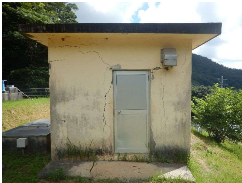
【 大勝浄水場：管理棟 】
