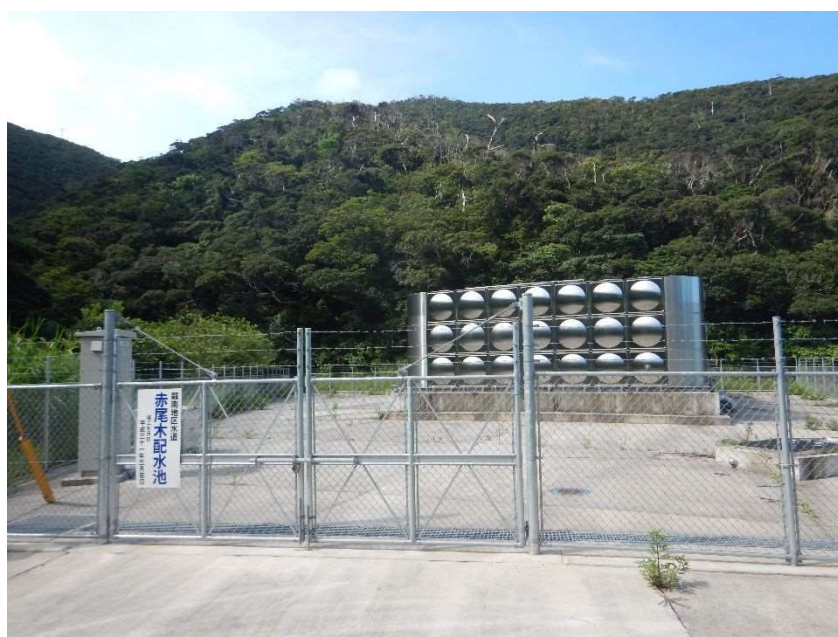
【 赤尾木配水池 】
