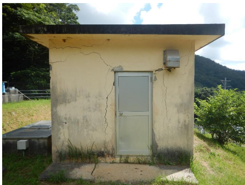
【 大勝浄水場：管理棟 】
