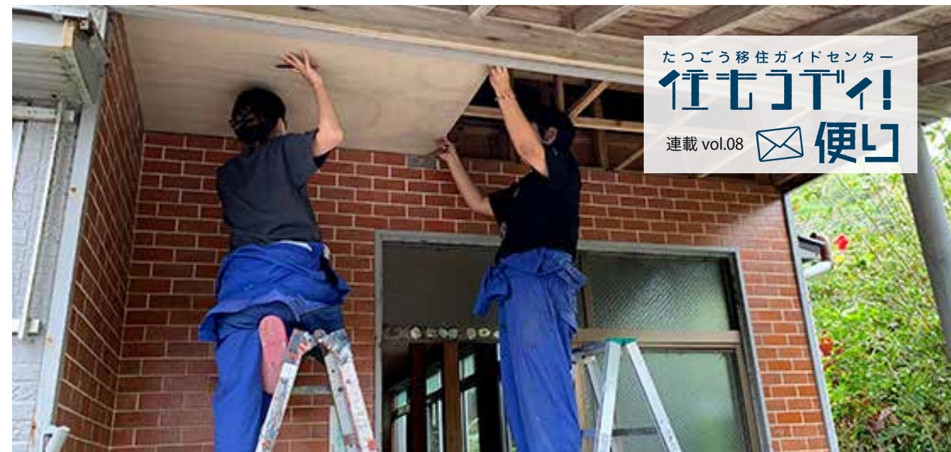
住居としての空き家活用に向けた改修作業の様子
