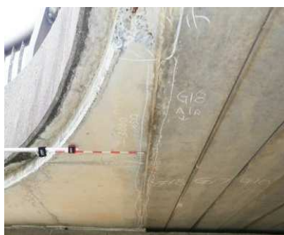
【健全度Ⅱ：屋入橋】
