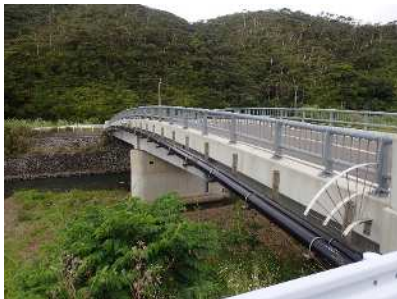
【健全性 I : アヒン橋】
