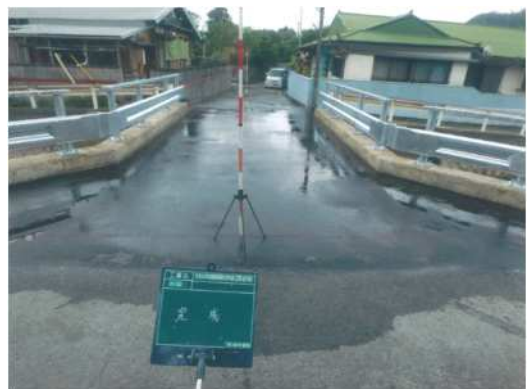
【前平橋：修繕後】
