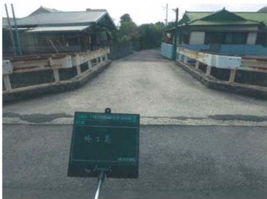
【前平橋：修繕前】
