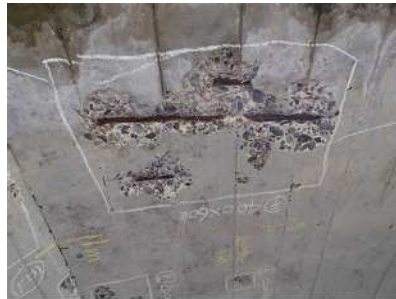
【健全性 II : 小勝橋】
