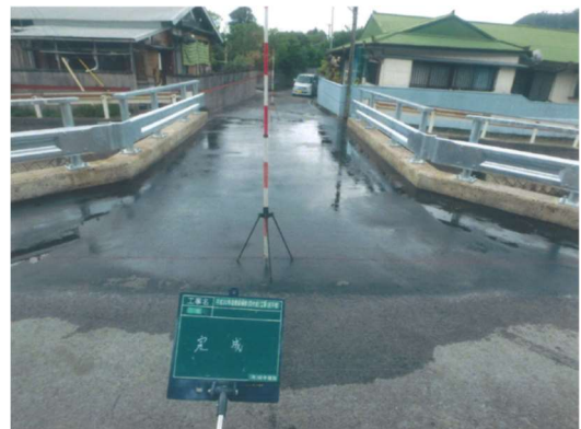
【前平橋：修繕後】
