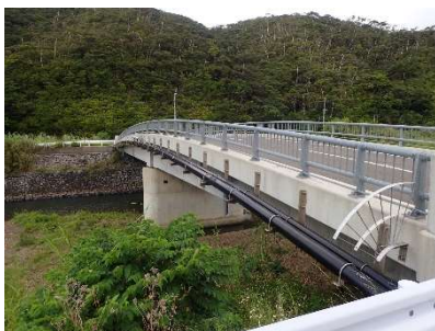
【健全性Ⅰ：アヒン橋】
