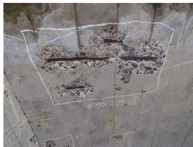
【健全性Ⅱ：小勝橋】
