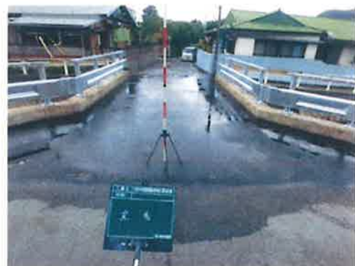
【前平橋 : 修繕後】
