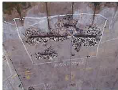
【健全性 II : 小勝橋】
