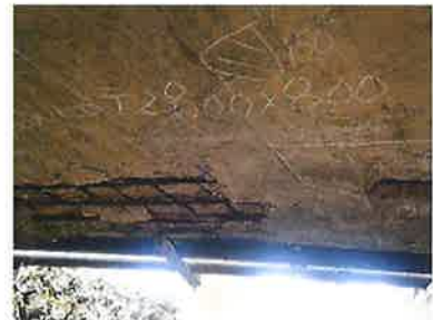
【健全性 III : 山田橋】
