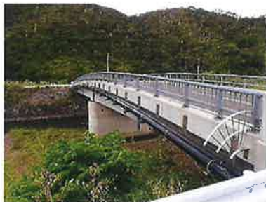
【健全性 I : アヒン橋】
