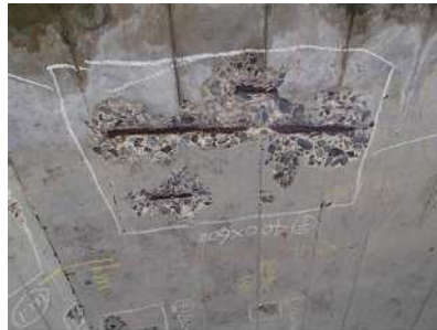
【健全性 II : 小勝橋】
