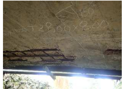
【健全性 III : 山田橋】
