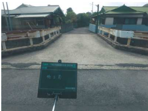
【前平橋：修繕前】
