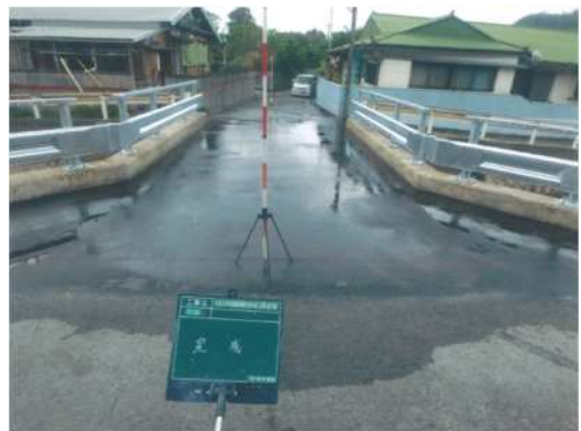
【前平橋：修繕後】
