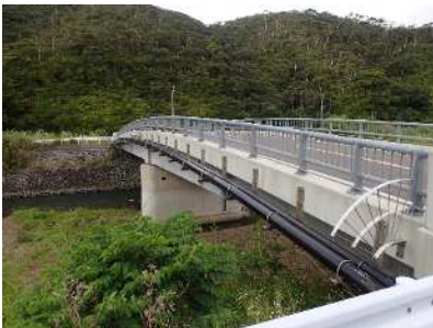
【健全性 I : アヒン橋】
