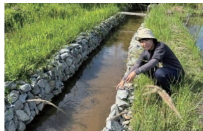
水路の 石積み作業の 様子
