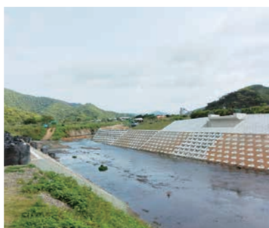
改修中の大美川
