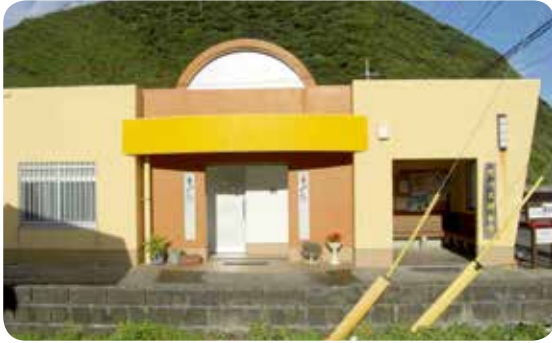
円集落に設置されているトイレ
