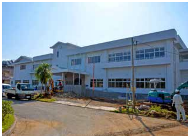
建設中の「りゅうがく館」
